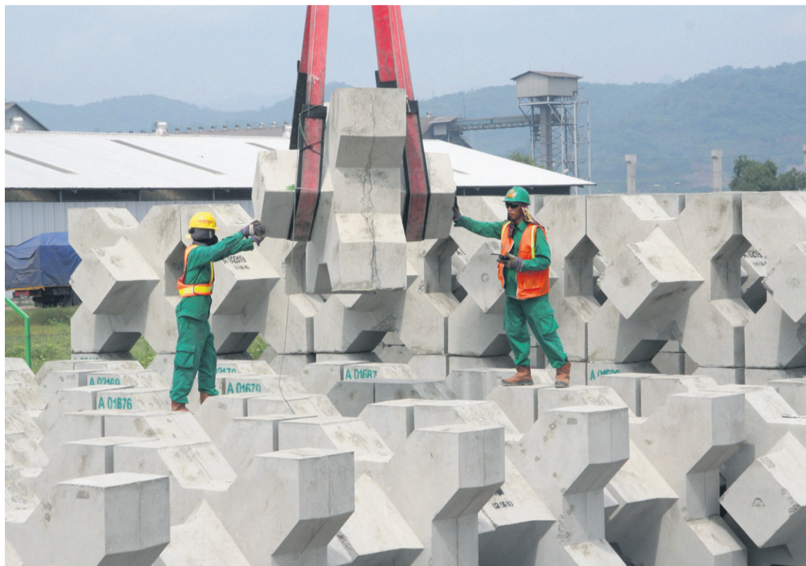
Op een braakliggend haventerrein produceert Decorient zo'n 40.000 Xblocs. De X-vormige betonnen blokken worden gebruikt voor de aanleg van een steiger en golfbreker bij het Australische eiland Barrow Island.
